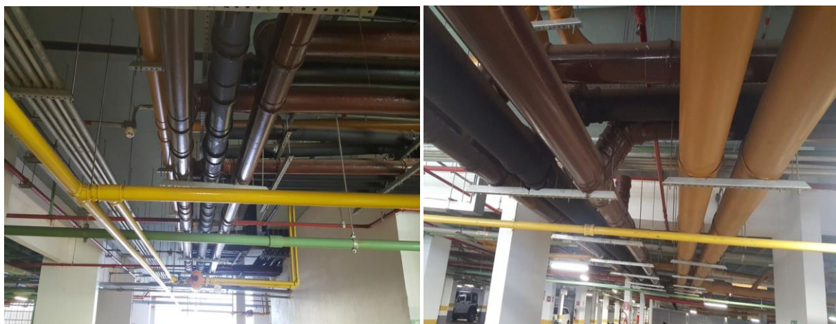
Figura 29-2.1 Pintura de toda tubulação de esgoto, aguas servidas, pluviais do primeiro e segundo subsolo.
