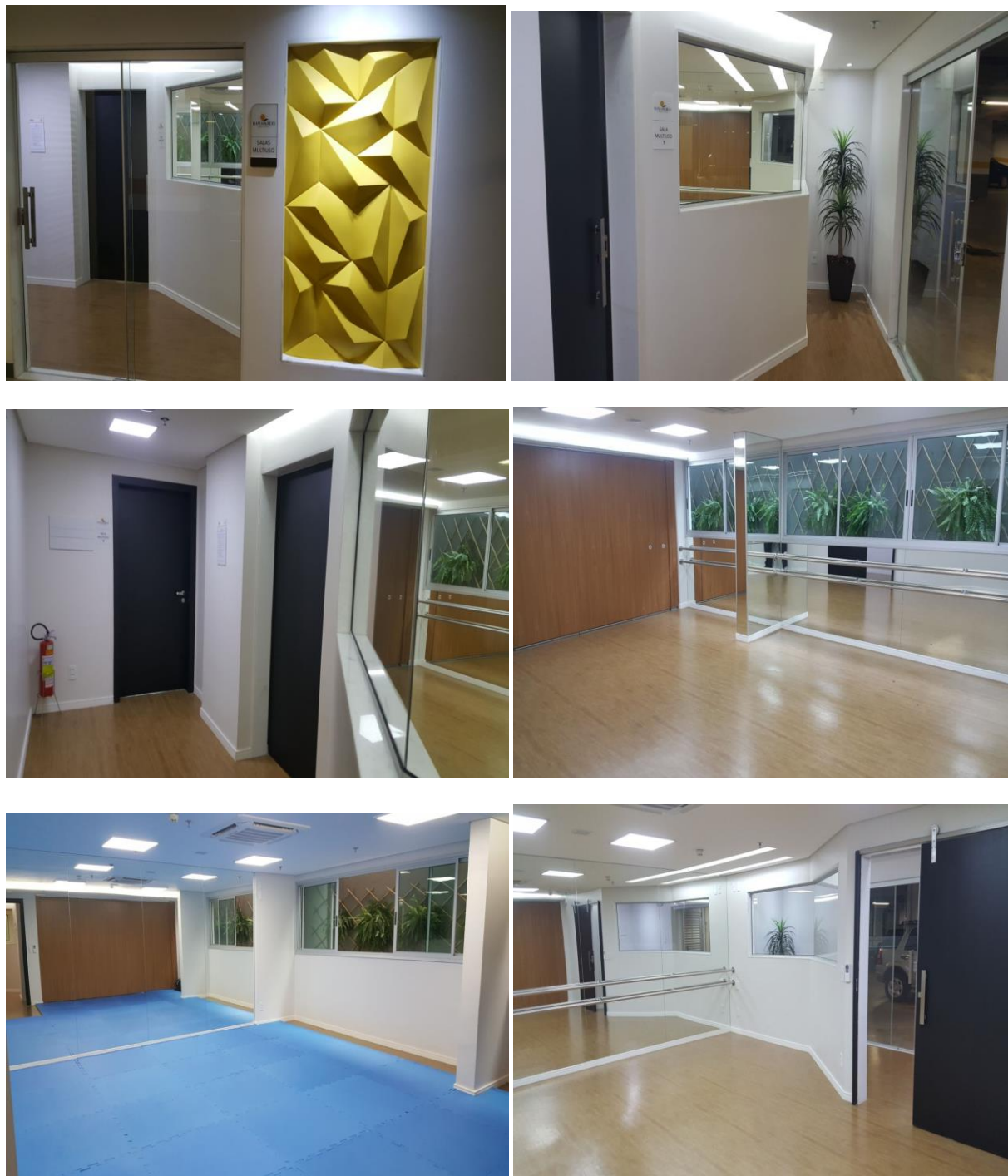
Figura 82-4.1 Construção de salas multiuso no segundo subsolo
