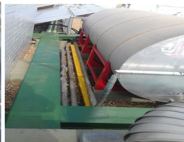
Figura 24-2.2 Fabricação e instalação de passarelas metálicas (proteção da canalização), em toda a extensão das coberturas torre 1 e 2.
