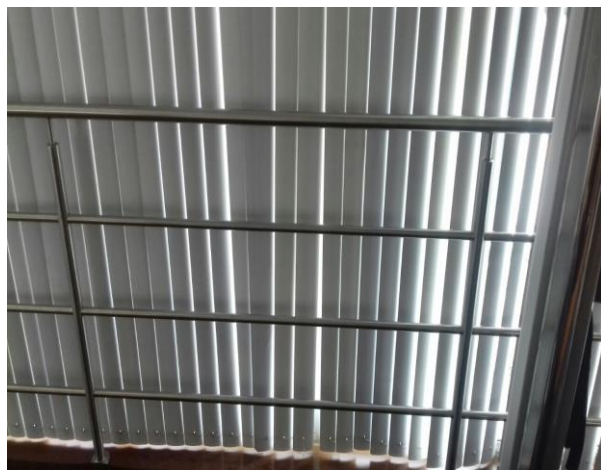
Figura 50-3.1 Instalação de corrimão em aço inox na academia para proteção dos usuários.
