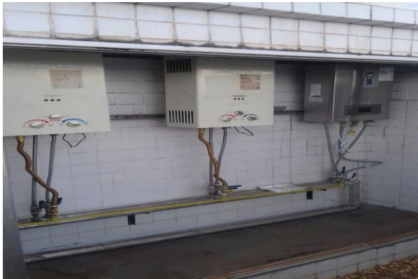
Figura 42-1.2 Compras de novos queimadores para sistema de água quente nas coberturas bem como substituição de várias placas e todos registros.
