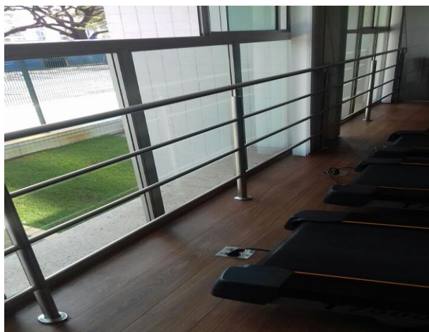
Figura 50-3.1 Instalação de corrimão em aço inox na academia para proteção dos usuários.
