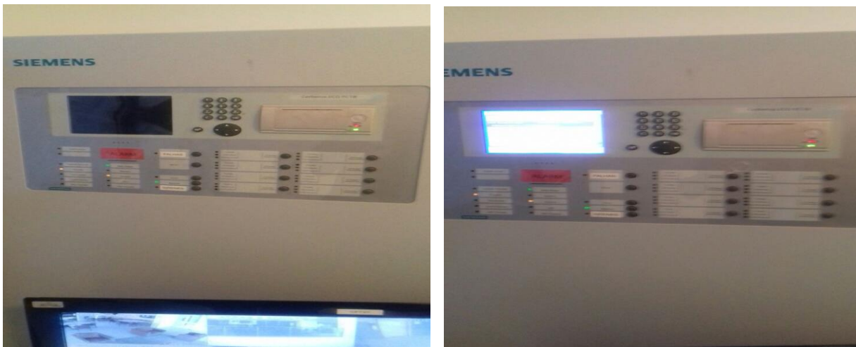
Figura 40-1.2 Formatação da central do sistema de detecção e alarme com trocas de peças.
