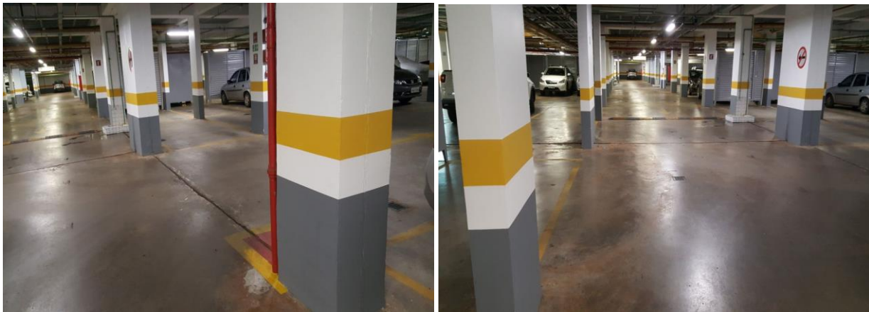
Figura 18-2.2 Colocação de cantoneiras (protetor de quina) em todos os andares churrasqueiras e hall dos banheiros dos pilotis.
