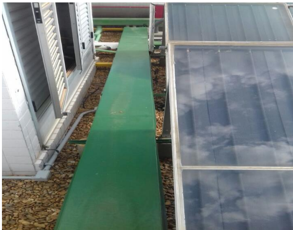
Figura 24-2.2 Fabricação e instalação de passarelas metálicas (proteção da canalização), em toda a extensão das coberturas torre 1 e 2.
